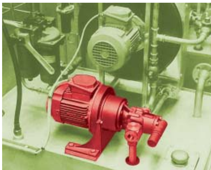
Pompe à engrenages SF dans une installation d'approvisionnement en fuel
