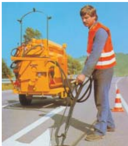
Fondoir à agitateur et machines à remplissage de joints
